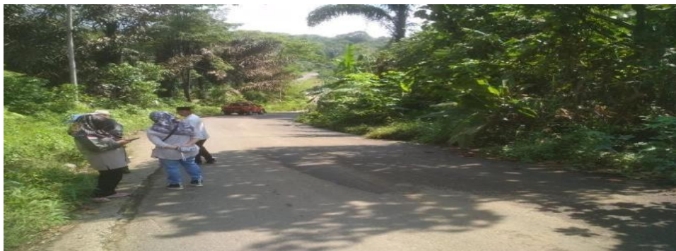
Gambar: Survey Lokasi Pasca Bencana Longsor Jalur Poros
