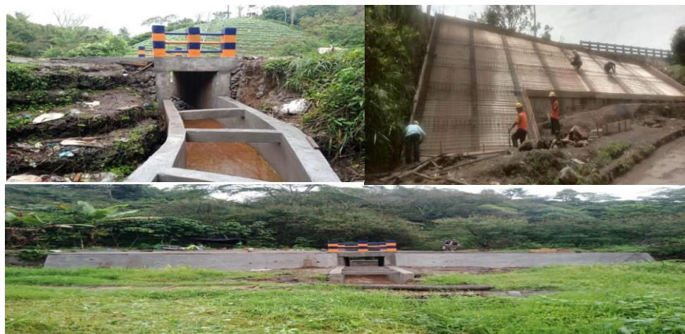
Gambar: Pembangunan Box Culvert di Desa Talang Lahat
