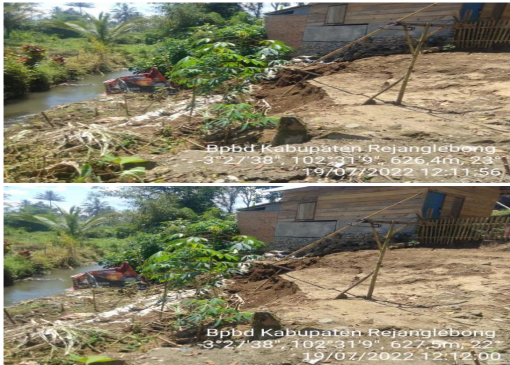
Gambar: Longsor di samping Rumah Warga Desa Batu Dewa
