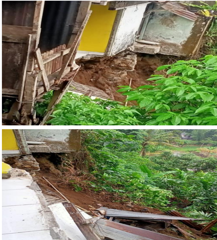
Gambar: Survey Lokasi Pasca Bencana RT 01/RW 05 Kampung Jawa
